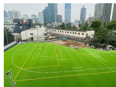
中之町幼稚園新園舎 (左奥)
